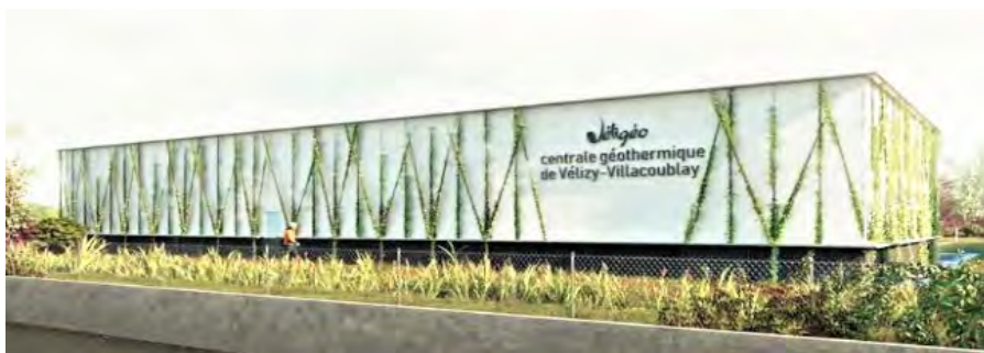
Figure 23 : Usine de géothermie de Vélizy-Villacoublay
